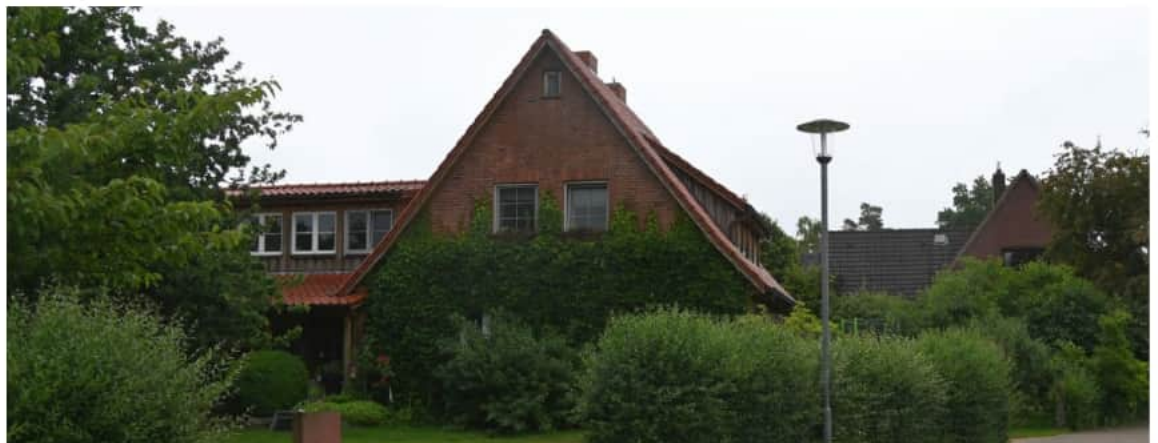
Blickrichtung Nordosten zu IO d12
