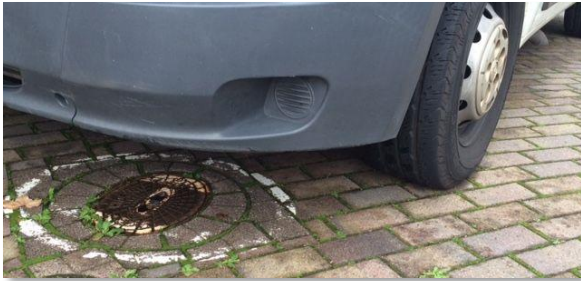
Bild 1: Auto über Unterflurhydrant
