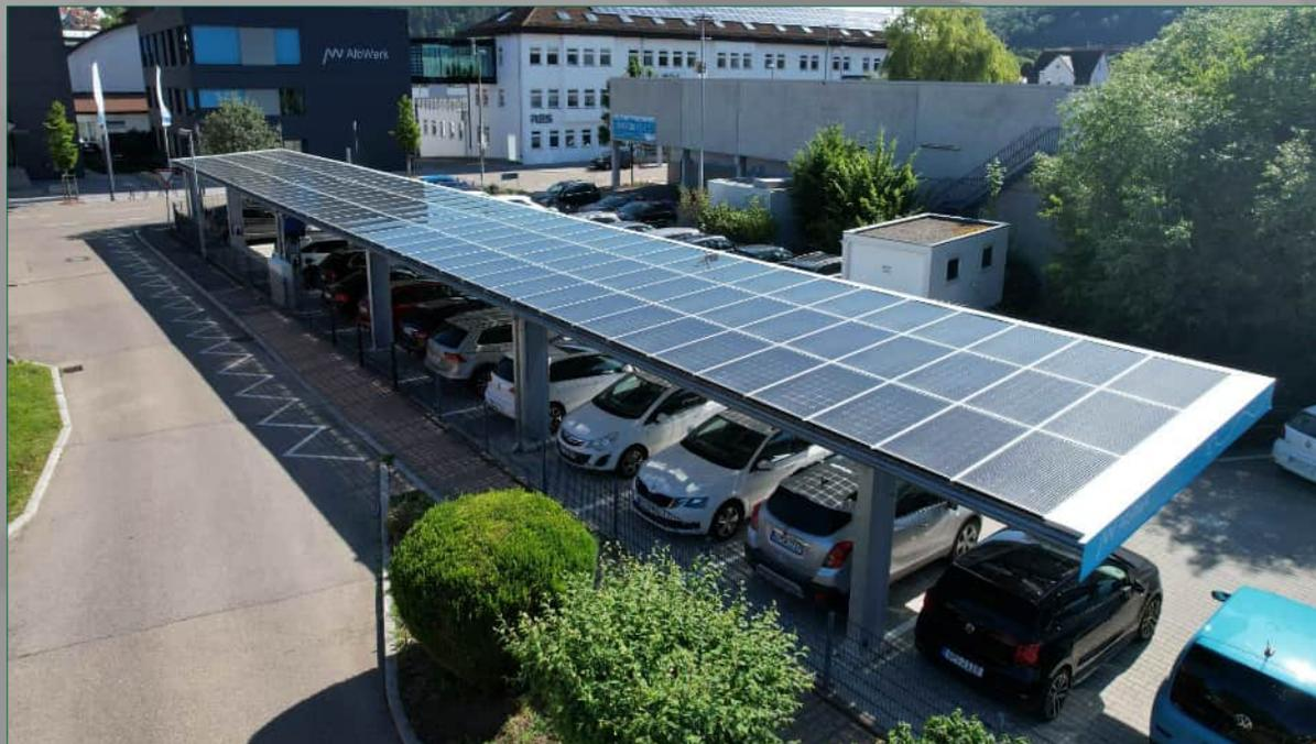
L-Träger-Überdachung mit semitransparenten Indach-PV-Modulen
