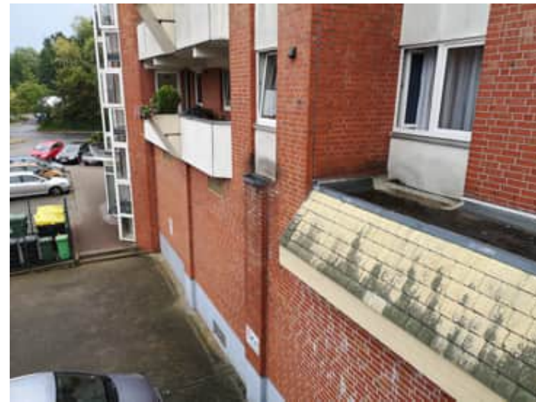
Gebäuderückseite, Verschmutzungen/Durchfeuchtungen
