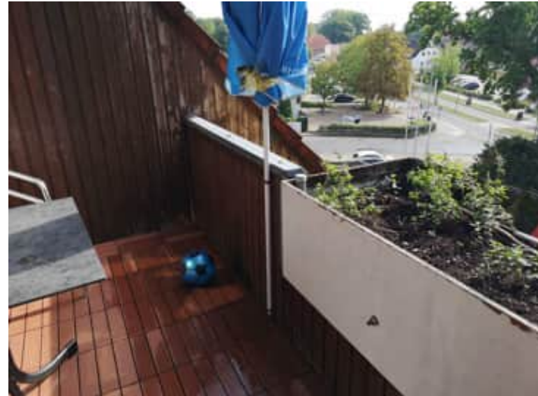
Loggia DG, Holzverschalung/Bodenbelag (Abdichtung/Dämmung)
