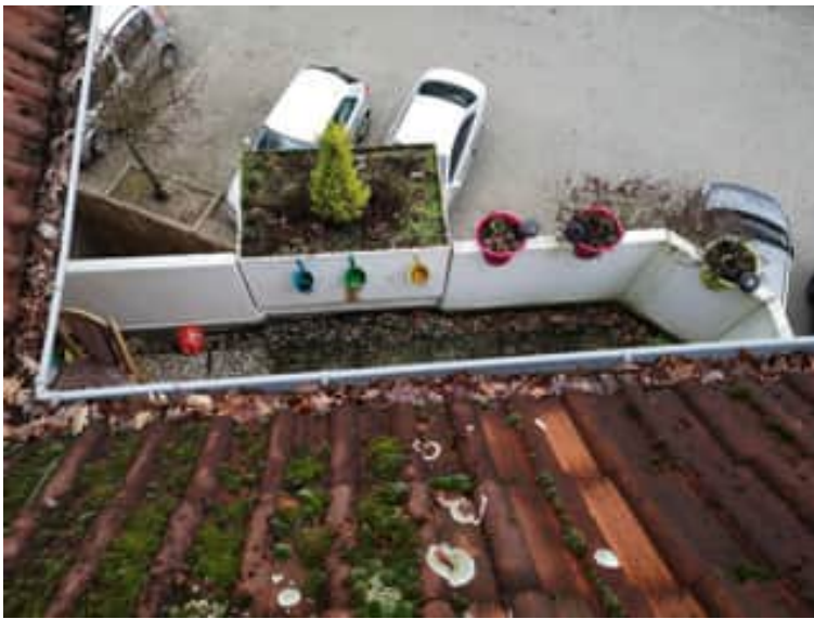
Dachdeckung Satteldach, Begrünungen/Verwitterung
