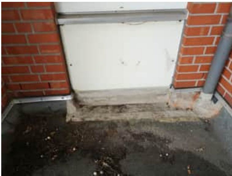
Flachdach über EG, Anschluss aufgehende Wand provisorisch
