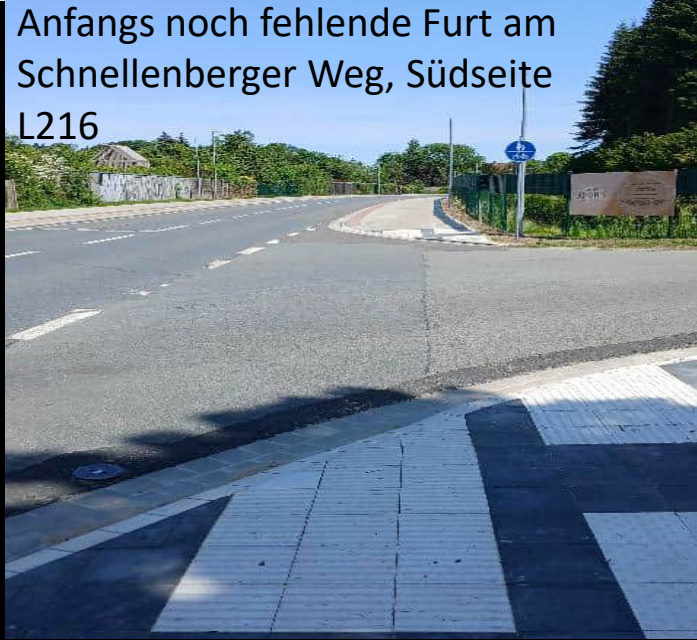
Gut: Inzwischen rot angelegte Furt am Schnellenberger Weg, Südseite L216
